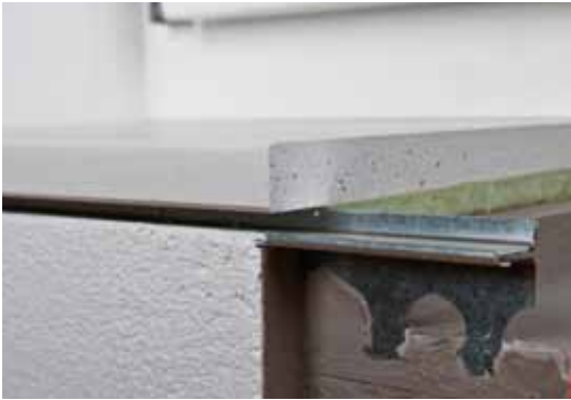
Einbau mit Schattenfuge (Profil erforderlich)
